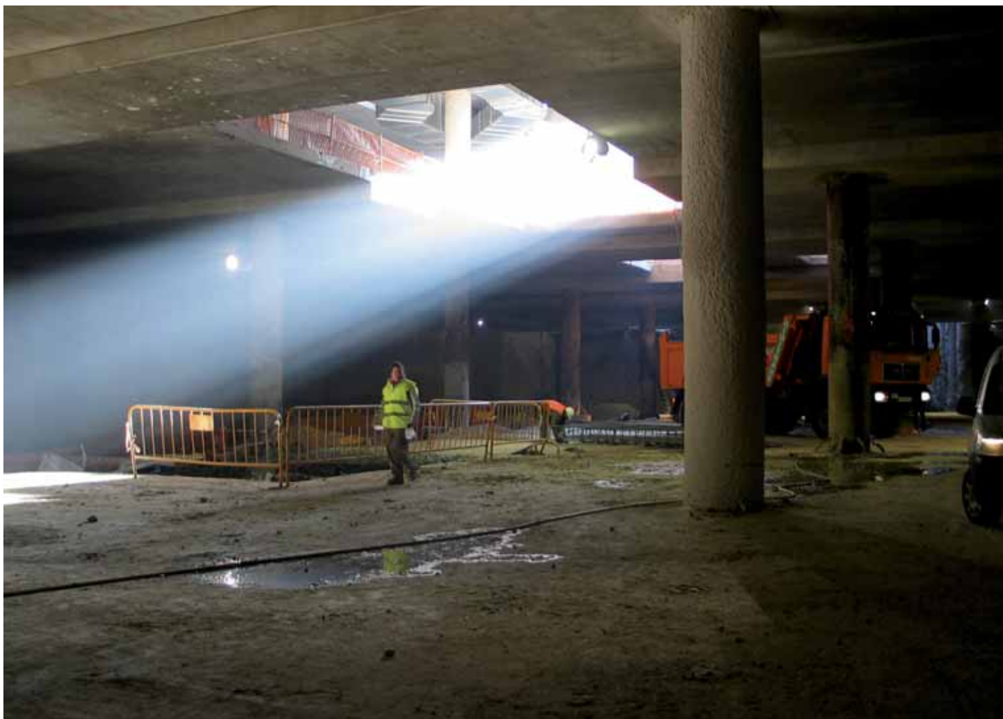
Excavación del nivel -1 Excavation of level -1
