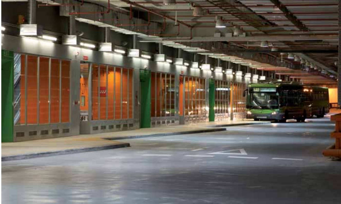
Zona de circulación de autobuses en nivel -2 / Bus manoeuvring area on level -2
