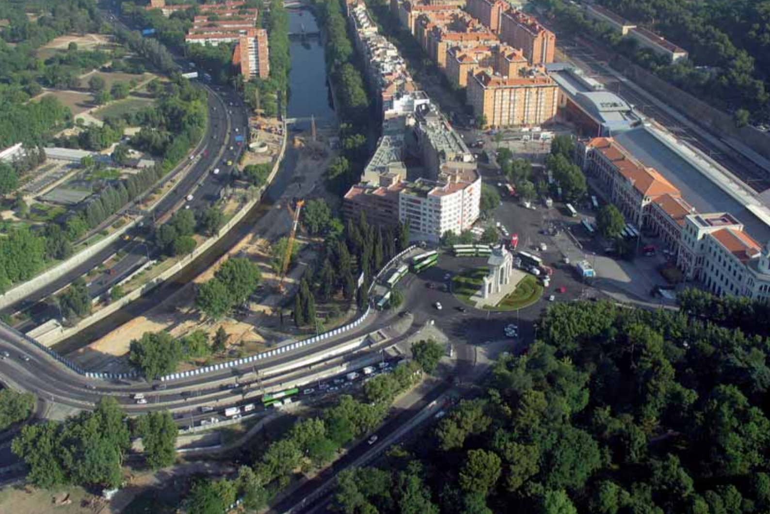
Vista aérea antes del inicio de las obras / Aerial view before work starts
